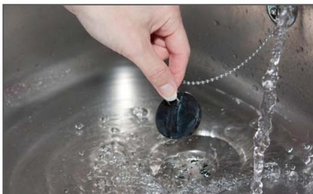
Plusieurs systèmes de vidage de bonde existent. Le système le plus ancien est à chaînette : d'une utilisation manuelle, le clapet se retire tout simplement à l'aide d'une chaîne. Plus récent, le vidage automatique permet l'ouverture et la fermeture du clapet avec un levier.
