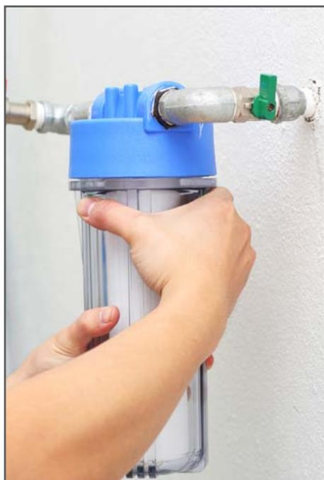
Le système le plus courant de filtre anti-calcaire est une cartouche contenant des polyphosphates : l'eau passe à l'intérieur et le calcaire reste en suspension dans l'eau au lieu de se déposer. En fonction de la dureté de votre eau, le filtre est à remplacer plus ou moins souvent.
