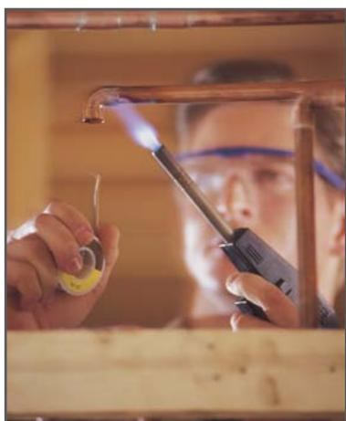
L'assemblage du cuivre se fait à l'aide d'un brasage (tendre ou fort) qui joint deux pièces à l'aide d'un métal d'apport. Il se distingue ainsi de la soudure qui permet de fusionner deux matières sans en rajouter une nouvelle.
