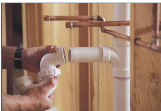
Le collage ne peut se faire qu'à froid, il est interdit de chauffer les tubes et raccords en PVC. Ces derniers doivent en plus avoir un repère de montage pour éviter les erreurs, il est possible de les faire au feutre.
