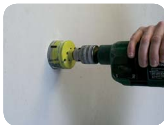
2 - Percer la plaque de plâtre.
