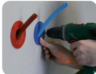
5 - Visser pour verrouiller le système.
