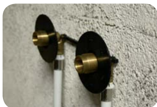
4 - Placer les cales noires des FIXOPLAC multicouche sur les raccords. Clipper le gabarit sur les raccords pour garantir l'entr'axe de 150 mm.
