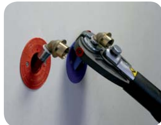
6 - Sertir les raccords et les repousser dans les modules.
