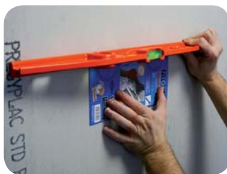
1 - A l'aide du gabarit fourni et d'un niveau, marquer l'emplacement.
