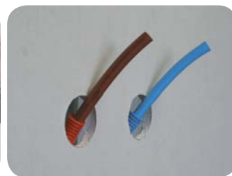
3 - Sortir les tubes P.E.R., les dénuder de leur gaine et couper à 10 cm.
