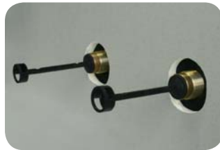
5 - Visser les guides sur les raccords, placer la plaque de plâtre et faire ressortir les guides dans les orifices.
