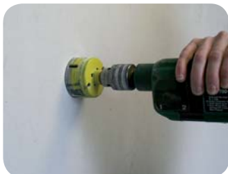
2 - Percer la plaque de plâtre.
