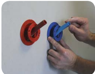
4 - Insérer les modules FIXOPLAC P.E.R.
