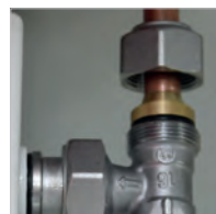
Placez l'adaptateur dans le robinet.
